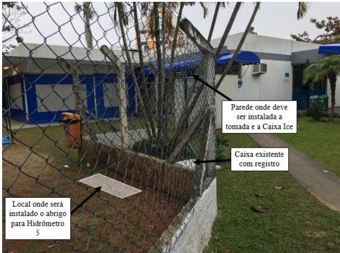
Figura 8 - Localização do registro existente, da instalação do Hidrômetro 5 e do ponto de energia.
