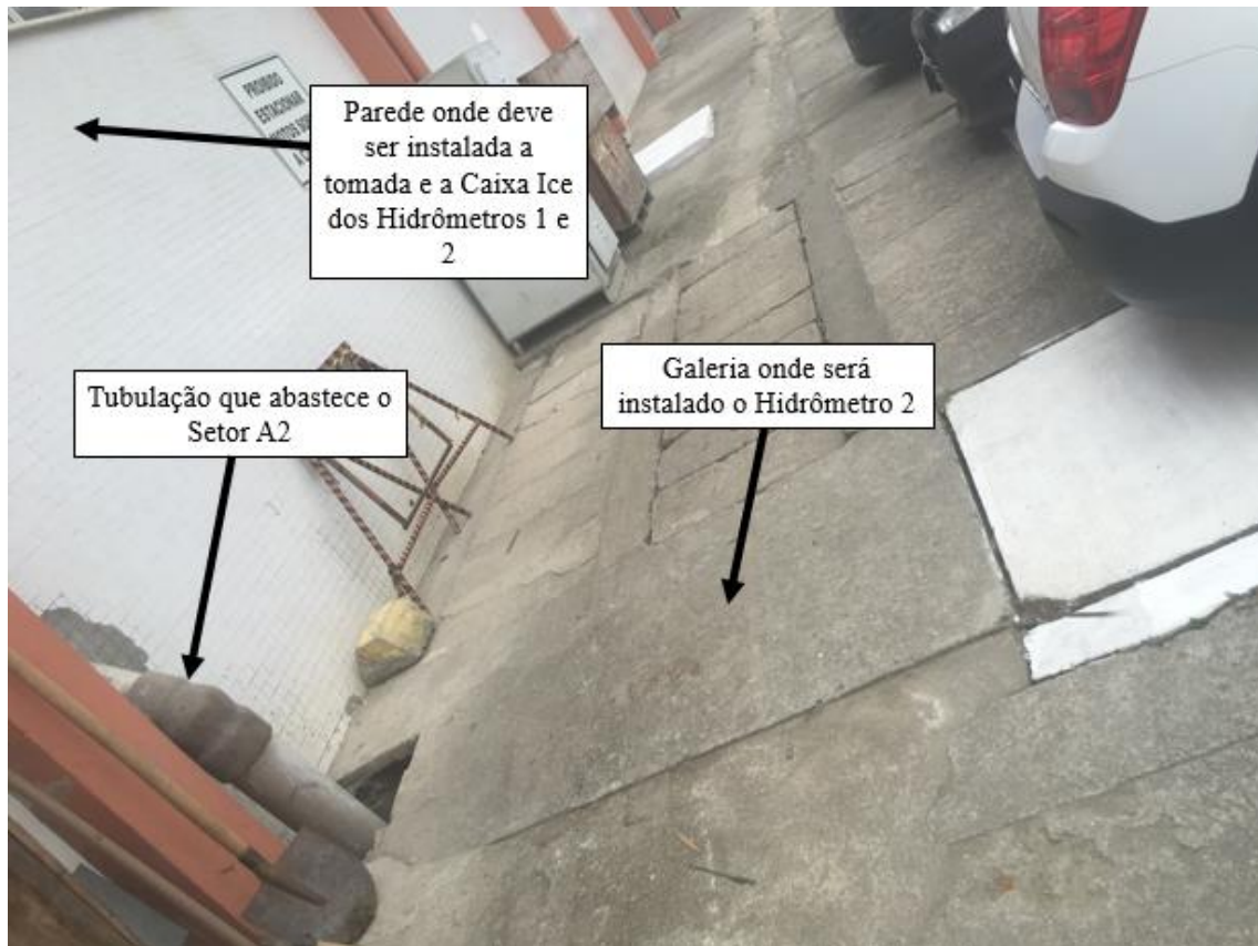
Figura 5 - Localização do registro existente, da instalação do Hidrômetro 2 e do ponto de energia.
