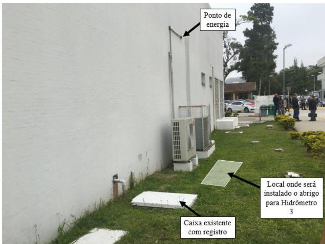
Figura 6 - Localização do registro existente, da instalação do Hidrômetro 3 e do ponto de energia.
